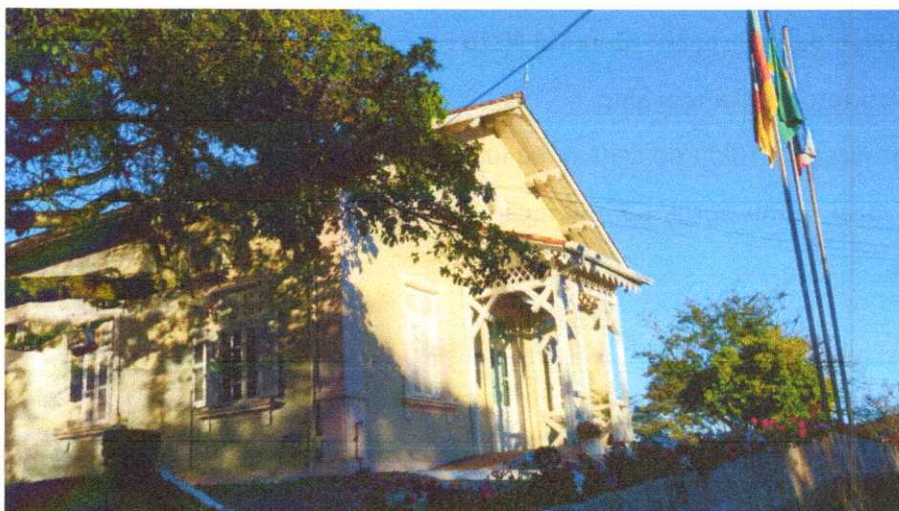
Figura 6: Prédio que abriga a atual Prefeitura Municipal
